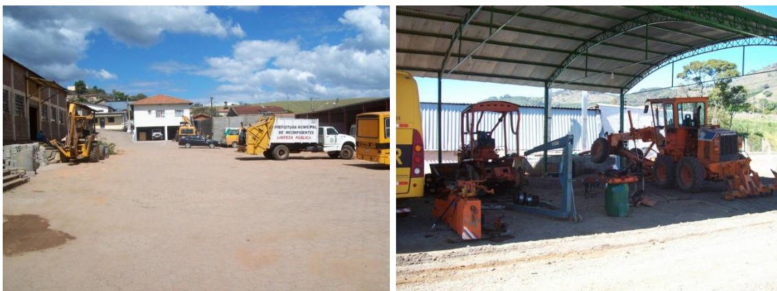
Figura 26: Unidade de apoio, Figura 27: Área de manutenção do almoxarifado do município de município de Albertina - (2013). Inconfidentes - (2013).
