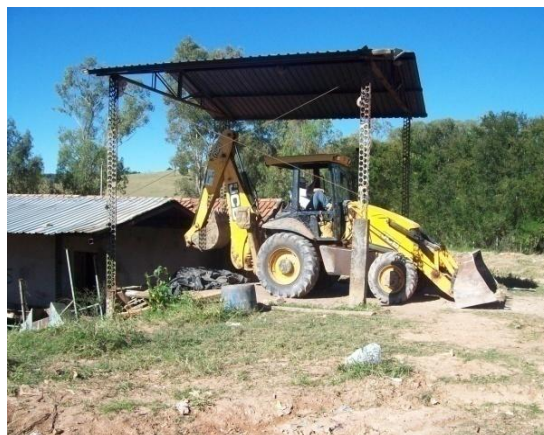
Figura 42: Máquina utilizada no recobrimento diário dos resíduos – (2013).
