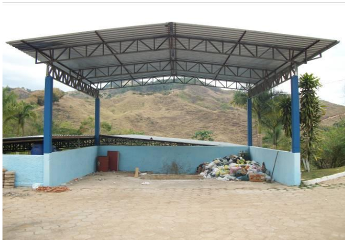
Figura 31: Área de recepção dos resíduos de uma Usina de Triagem e Compostagem.
