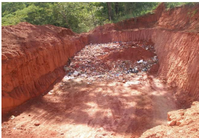
Figura 35: Vala de aterramento dos rejeitos.
