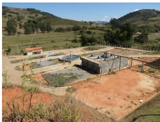
Figura 18: Vista geral da ETE.
