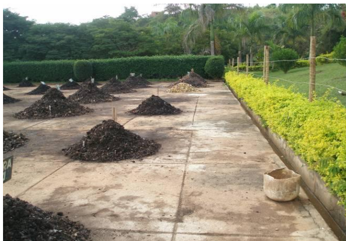
Figura 33: Pátio de Compostagem, observa-se na lateral sistema de drenagem.
